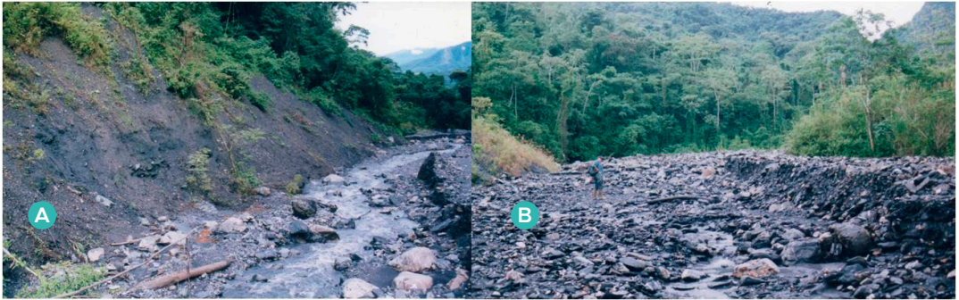
FIGURA 10. Zona de acumulación de sedimentos gruesos de quebrada Negra (No. 24): A) muy próxima a la confluencia con quebrada Blanca (No. 25) y, B) cerca de la zona de depositación (futura plazoleta de sedimentación). Fotografías tomadas por C. Ferrer, 2005
