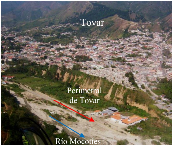
Figura 7. Vista panorámica aérea de una parte de la Perimetral de Tovar, la cual se constituyó en una de las áreas de más afectadas por parte del río Mocotíes durante el evento del 11/02/2005. Al fondo se observa la ciudad de Tovar, emplazada sobre abanicos aluviales coalescentes del Pleistoceno Tardío. (Imagen cortesía del vuelo ULA-INTI-Ejército del 26/02/2005)
