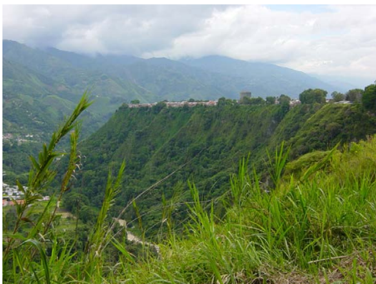
FIGURA 8. Talud sobre río Chama (2002). Fuente: fotografía del autor.
