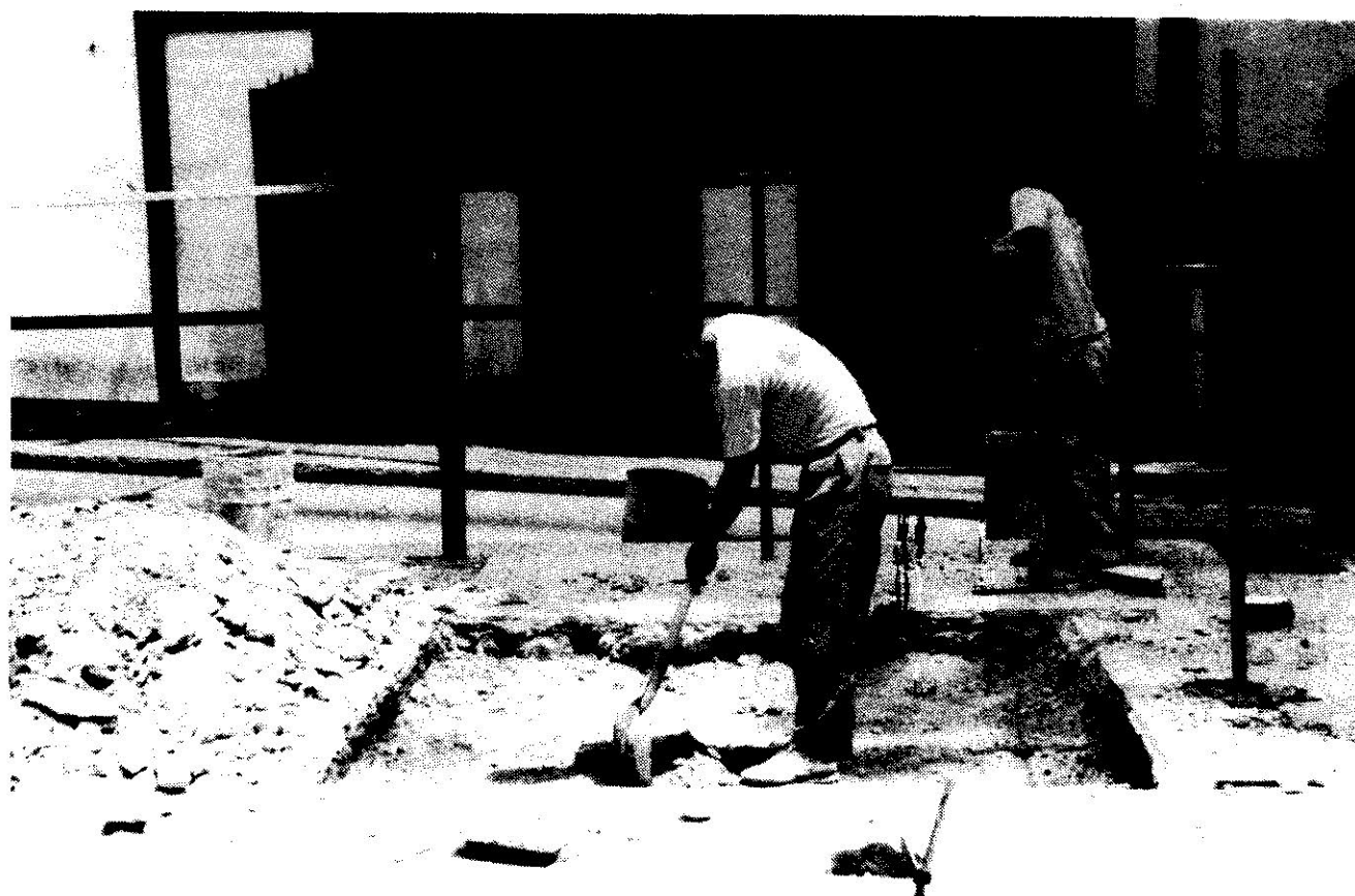
Iglesia Dulce Nombre de Jesús, Petare (Caracas). Corte 3 - Trabajos de excavación.
