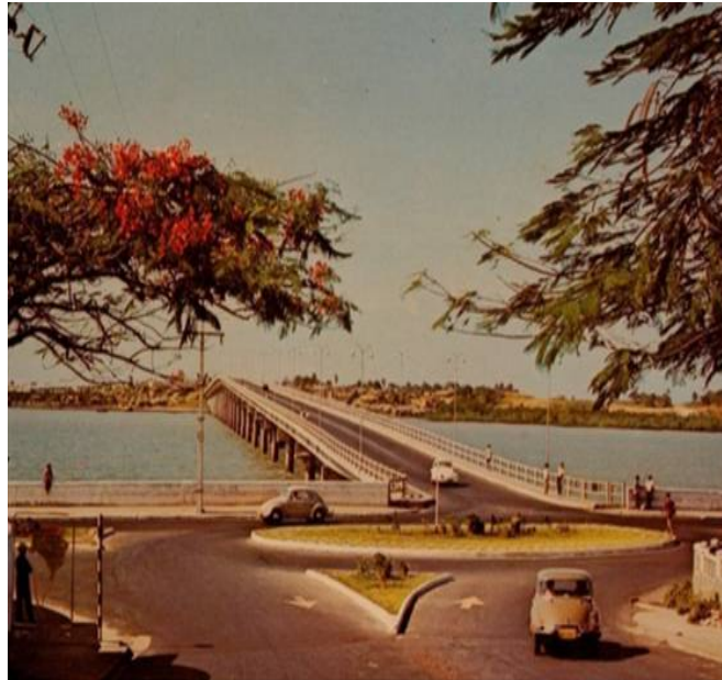
Figura 2 Ponte do São Francisco - São Luís (MA)
