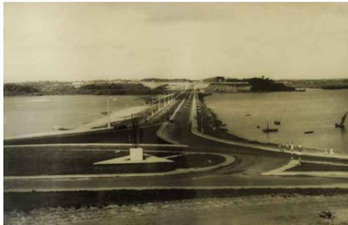
Figura 3 Barragem do Bacanga - São Luís (MA)
