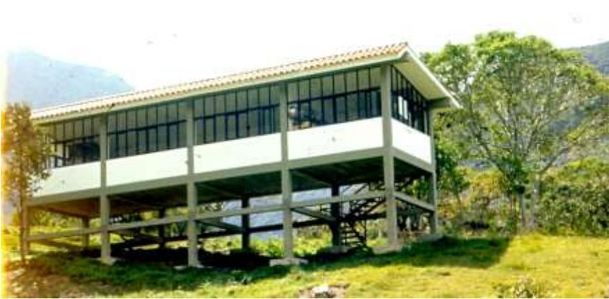
Fig. 184. Insectario permanente. Construcción sobre columnas para aislarlo del suelo. La base da cada columna está rodeada por una tanquilla llena de agua o gasoil, para evitar la entrada de animales rastreros.
