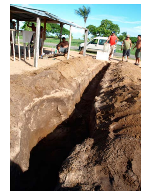
Foto 5. Zanja para red eléctrica de Awala-Yamilapo. Foto: Félix Tiouka.
