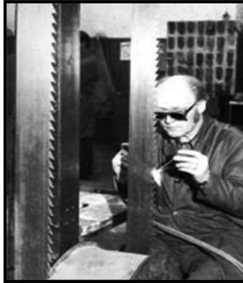
**Figura 6.** Aplicación de estelita manual con equipo de oxiacetileno
