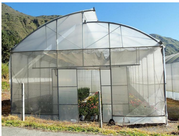
Figura 3. Fotografía del invernadero donde se aprecia la malla de sombreo móvil.
