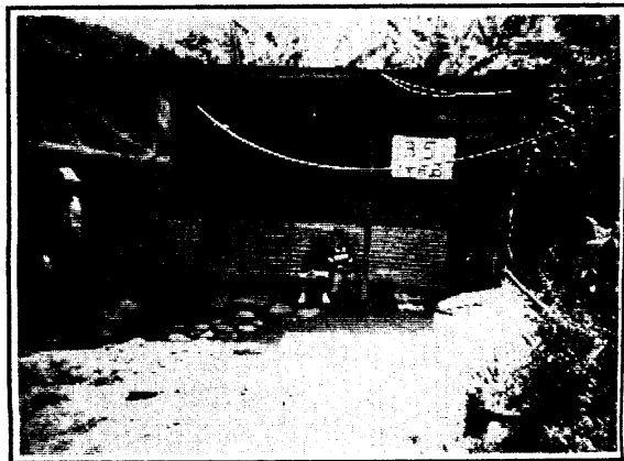
Vivienda número 35 en el barrio Andrés Bello, construída fundamentalmente por planchas de zinc. (Mérida, 1991)
