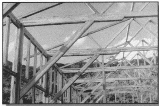
**Figura 4.** Galpón con estructura de madera en Caritupe estado Falcón, calculada por el método de esfuerzos adminibles (WSD).
