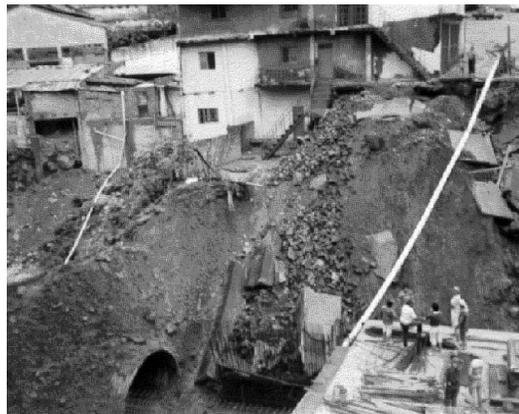
**Figura 2.** Daños causados por la quebrada La Bermeja a viviendas e infraestructura de la ciudad de San Cristóbal (sector La Guacara).
