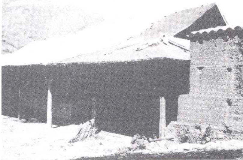
Foto 4: Edificación del trapiche Los Clavos. Boconó, Estado Trujillo.
