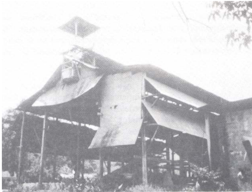
Foto 6: Edificación del Central Sicarigua, Edo. Lara.
